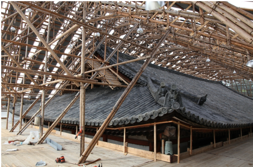
※法隆寺大講堂修復現場
