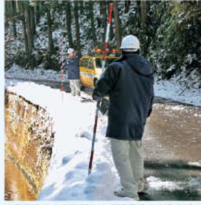
県五條土木事務所による迂回路の安全点検 (野迫川村今井の林道)
