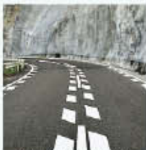
減速路面標示の設置
