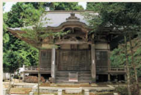
百貝岳の中腹にひっそりとたたずむ真言宗のお寺。理源大師が建立したと伝わる。寺に退治された大蛇の頭骨が残されている。
