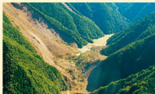
土砂崩落により川の流れがふさがれて水がたまる河道閉塞が多発(五條市大塔町赤谷)
