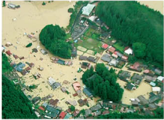
坪内地区 河道閉塞により川の水位が上昇し、浸水した家屋(奈良県警察「あすか」撮影)
