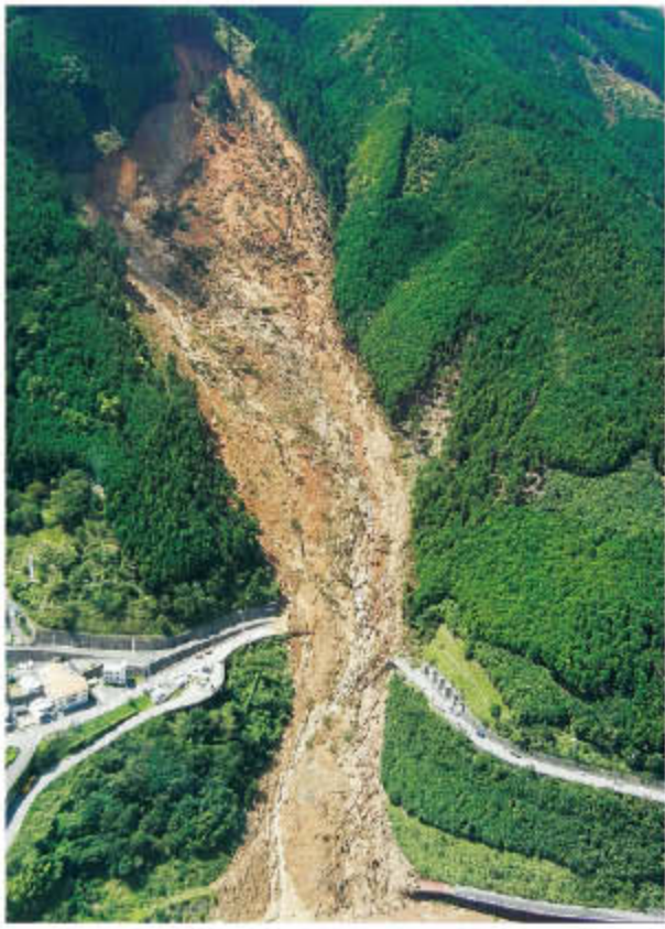
迫地区 山腹崩壊の現場
