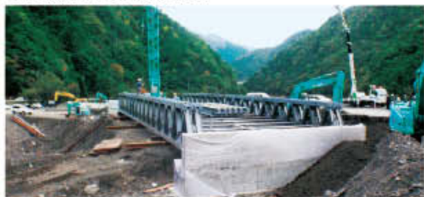
国道168号の復旧工事のようす(11月8日撮影)
