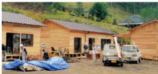
仮設住宅の建設工事のようす(11月5日撮影)
