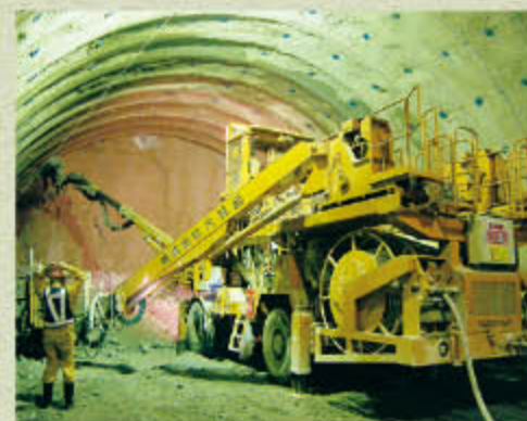
巨勢山トンネル
