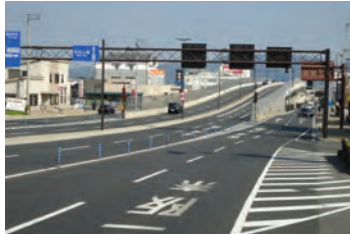
大宮道路(平面4車線、写真①)
