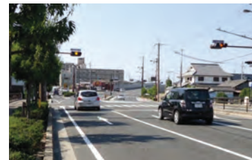
三条道路(平面4車線、写真⑤)
