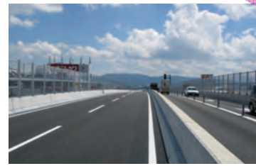
大宮道路(高架4車線、写真③)
