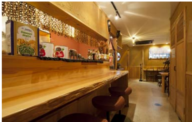
カウンターの端は、面皮の趣を出すよう大工の手仕事で仕上げている。
