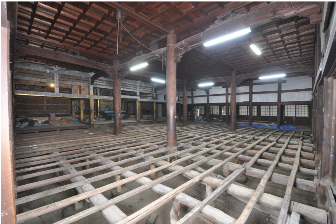
写真2 本堂内部状況
