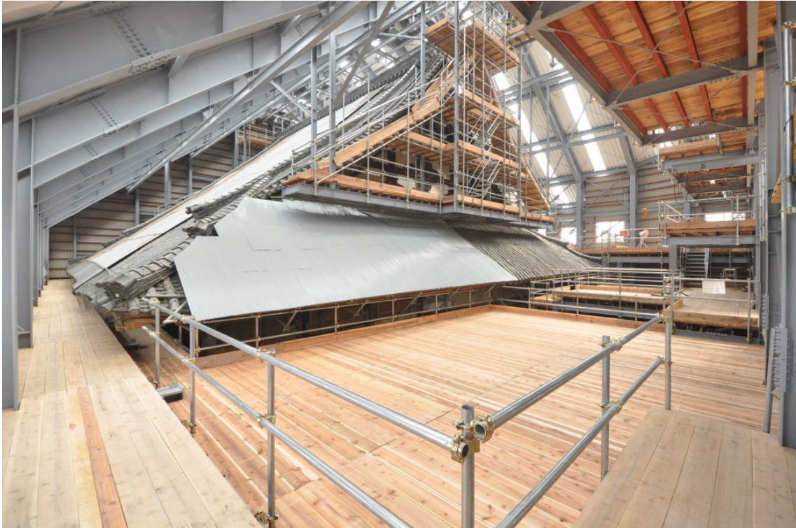
写真1 素屋根内部状況
