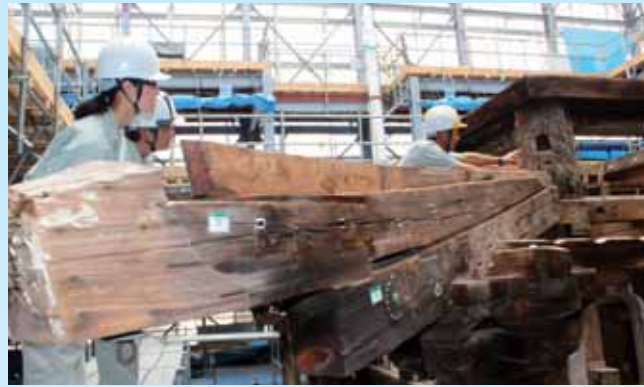
薬師寺東塔では平成30年までの間、全ての部材を解体して組みなおす、創建以来最大規模の修復が行われています。
