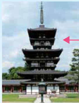
薬師寺東塔（国宝）上の写真は、矢印部分の修復
