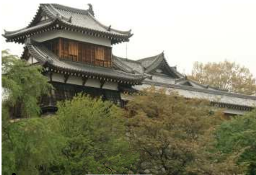
① Le château et la ville sous les remparts
