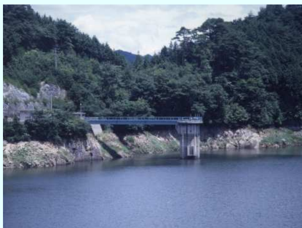
取水塔(室生ダム)
