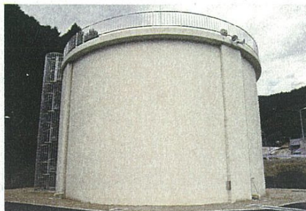
生物接触ろ過洗浄水槽
