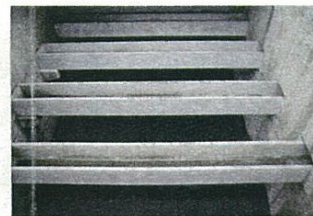
生物接触ろ過池内部
