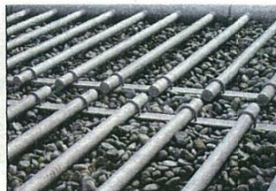
空気洗浄管及び支持砂利
