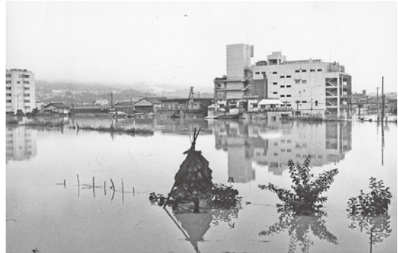
浸水した王寺駅南側 (写真提供：奈良新聞社)
