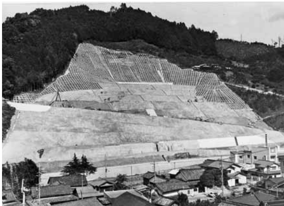
2年後に工事完了した西吉野村屋那瀬・和田の 山崩れ現場（写真提供：奈良新聞社）
