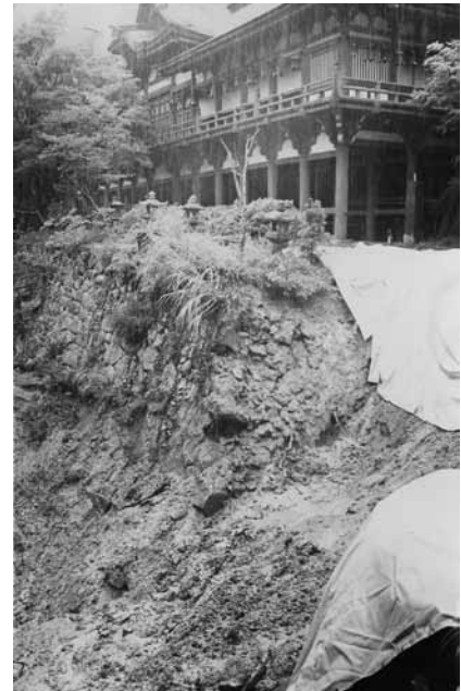
談山神社拝殿脇で石垣と土手が崩壊 (写真提供：奈良新聞社)
