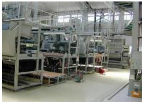
機械化された大型自動製茶工場
