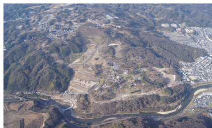
亀の瀬地すべり地区
