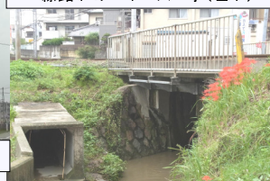
線路下のバイパス工事(左下)
