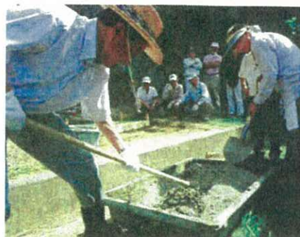
基礎コンクリート打ち
