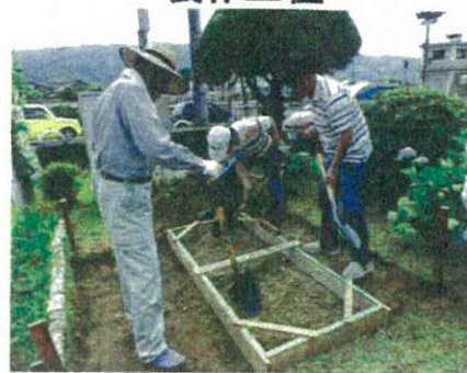
整地・基礎枠設置
