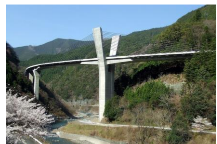
平成30年3月18日に開通した一般国道168号 五條新宮道路 辻堂バイパスの夢翔大橋
