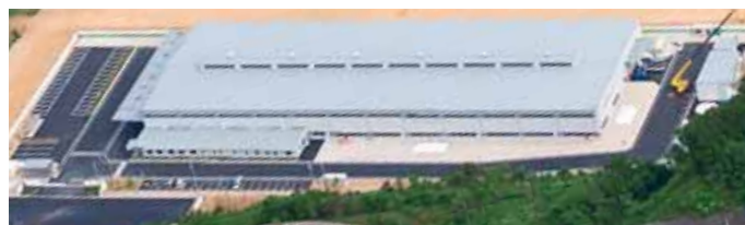
奈良県南部地域で敷地面積最大となる五條工場。今年の9月より本格稼働。新商品Live Naturalプレミアムの表面化粧材「無垢材挽き板」を製造する。
