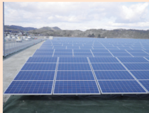
メガソーラー発電所（大淀町）
