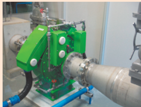
上津ダム小水力発電機（山添村）
