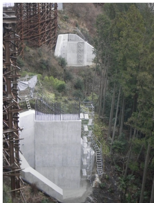
P2 橋脚、P3 橋脚
