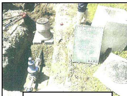
用水設備(配管等)の整備
