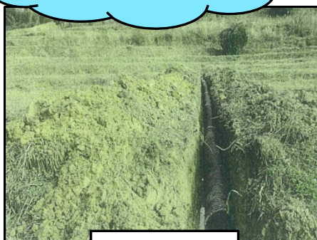
暗渠排水整備
