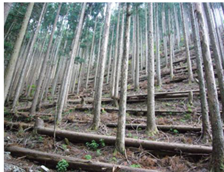
間伐木を利用した筋工の設置
