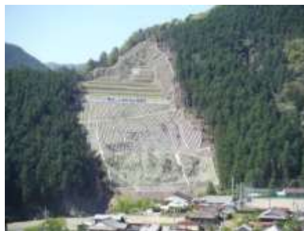
民有林直轄治山事業 十津川村折立
