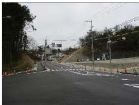
一般国道309号 車坂工区 (吉野郡大淀町下泷)
