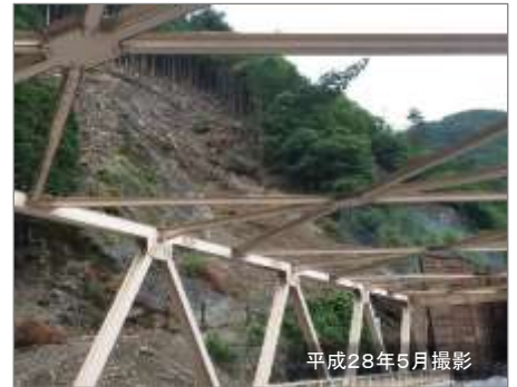
《道路防災対策》
