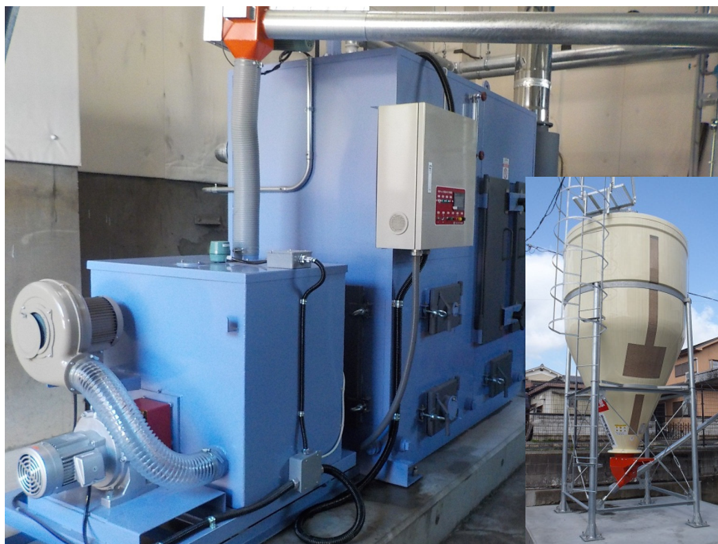
ボイラー本体
