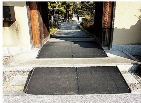
↑西門の段差解消スロープ
