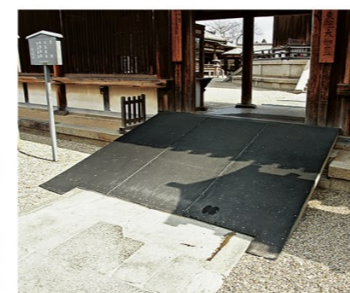
↑夢殿入口の段差解消スロープ
