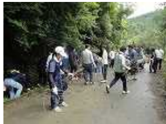
側溝から倒木を取り除く
