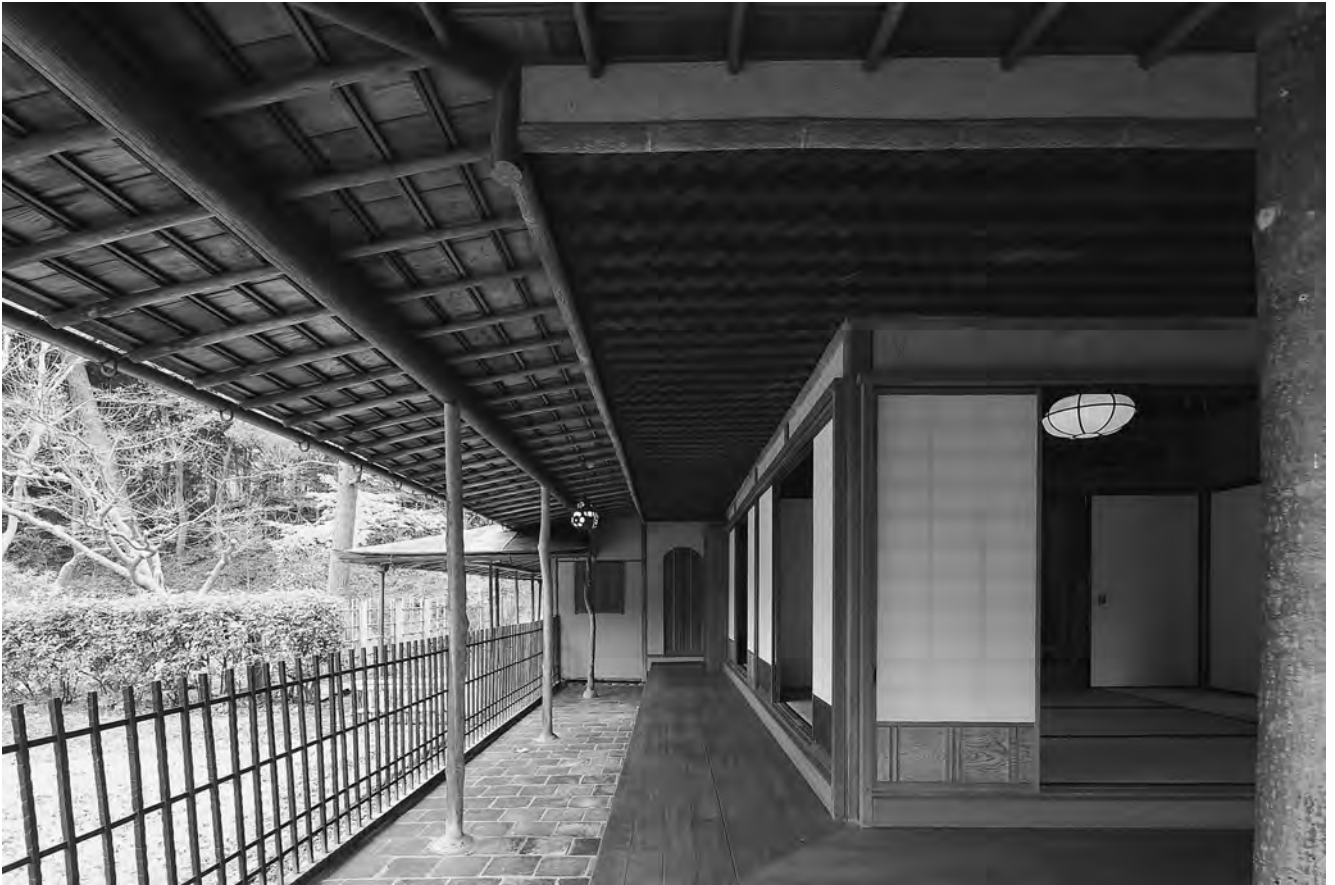
離れ座敷 縁・庇廻り 北より
