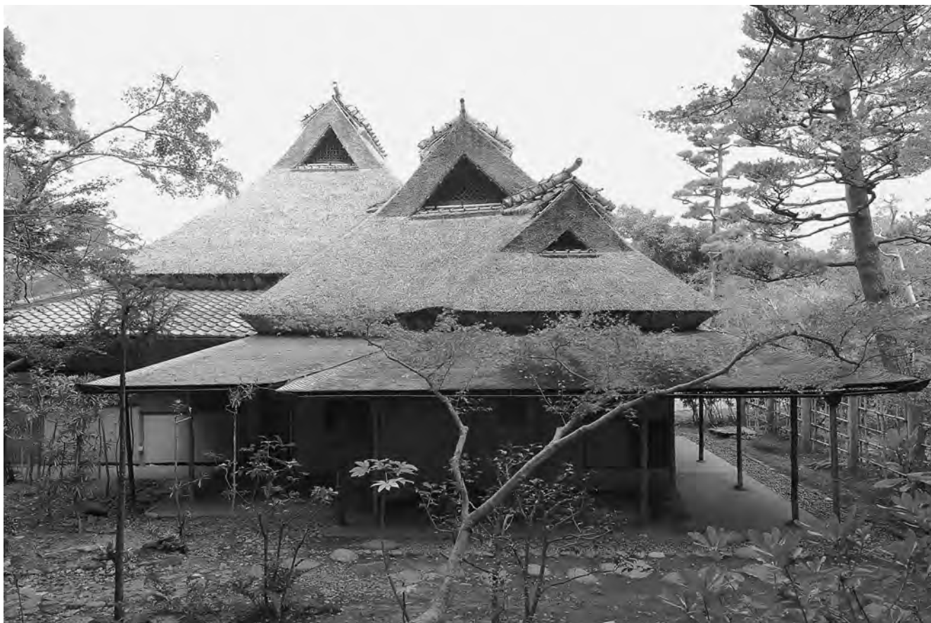
離れ座敷 全景 南より
