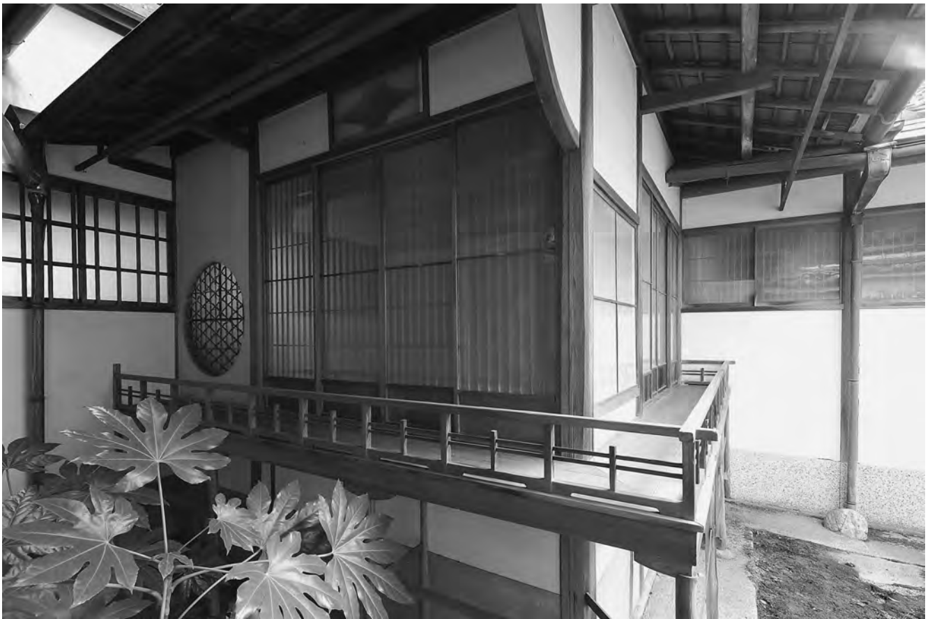
主棟（南廊下棟）竹の間 外部 北西より
