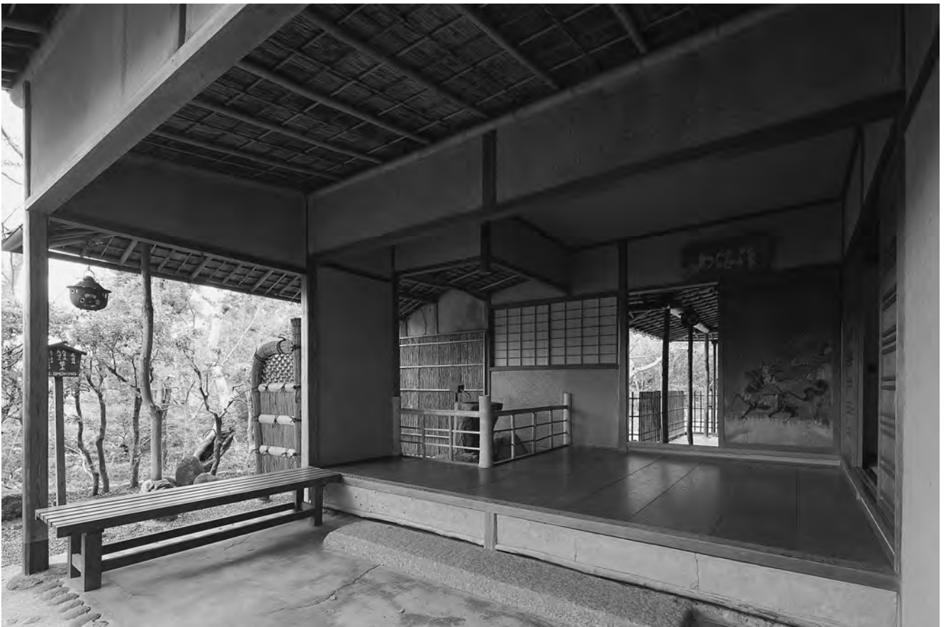
離れ座敷 玄関・手水 南西より
