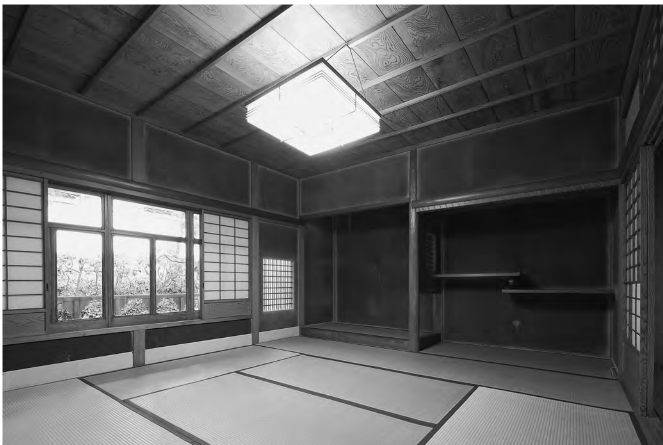
主棟（南棟）雉子の間 北東より
