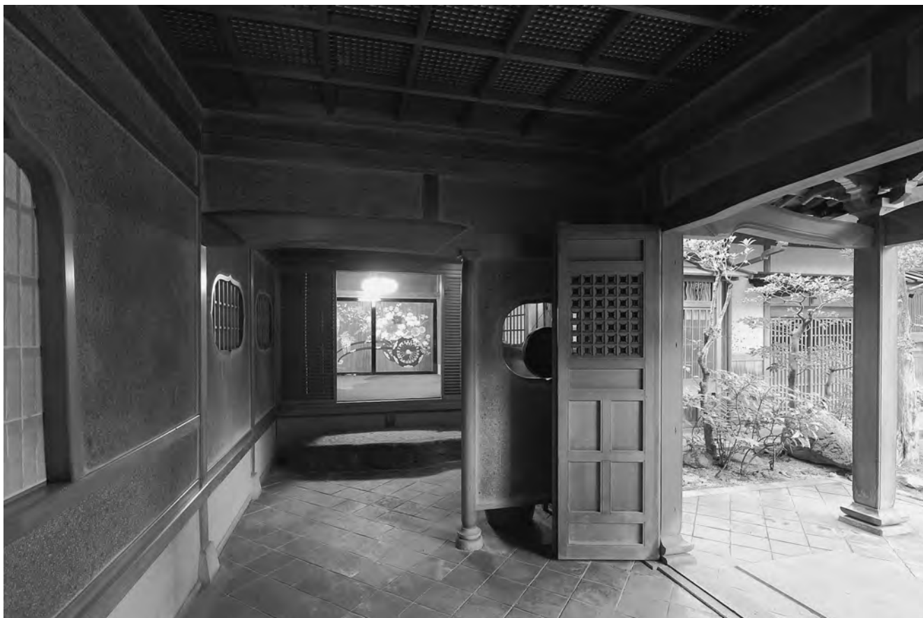
主棟（北廊下玄関棟）玄関内部 北より
