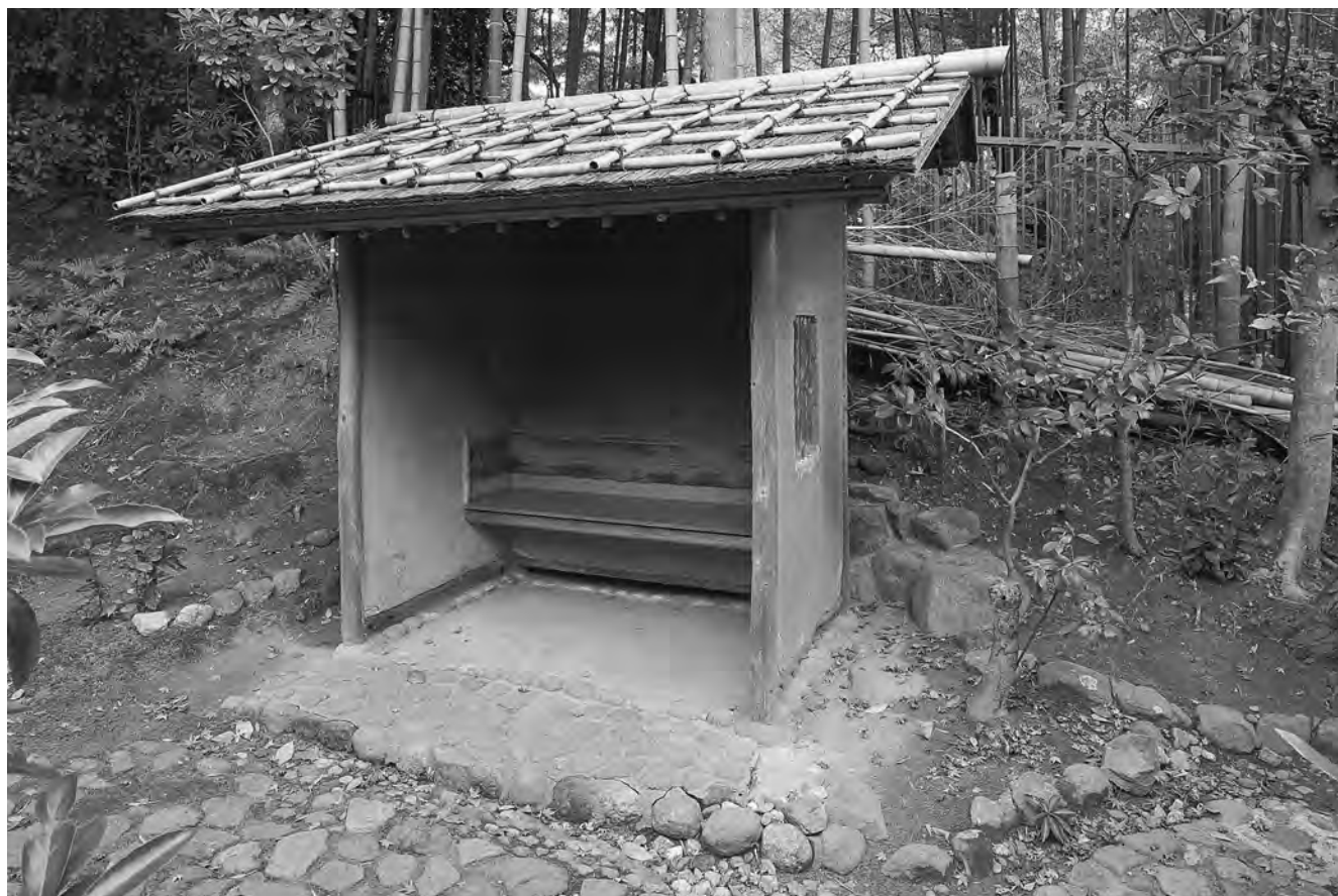
腰掛 全景 東より
