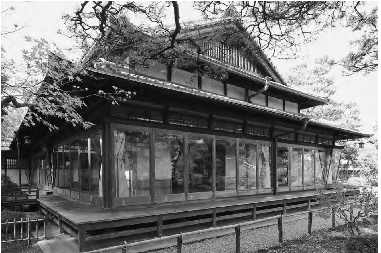
主棟（中央棟）全景 南東より
