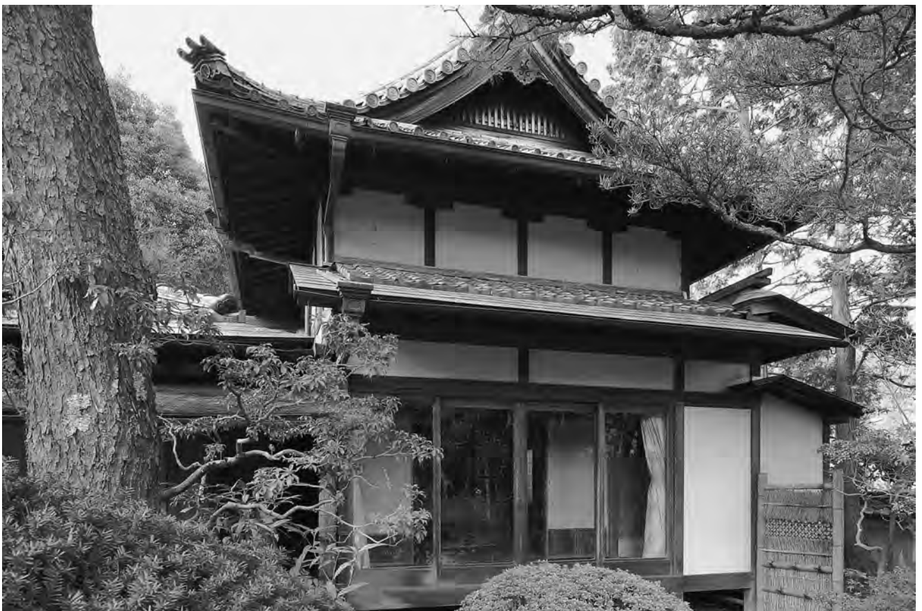
主棟（北棟）全景 東より
