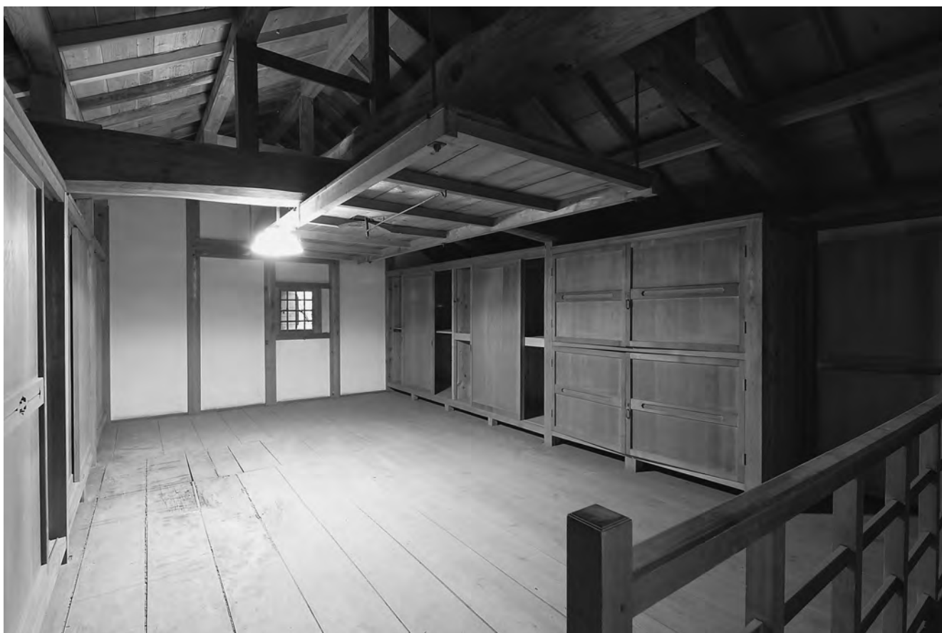
土蔵（東）二階内部 北東より
