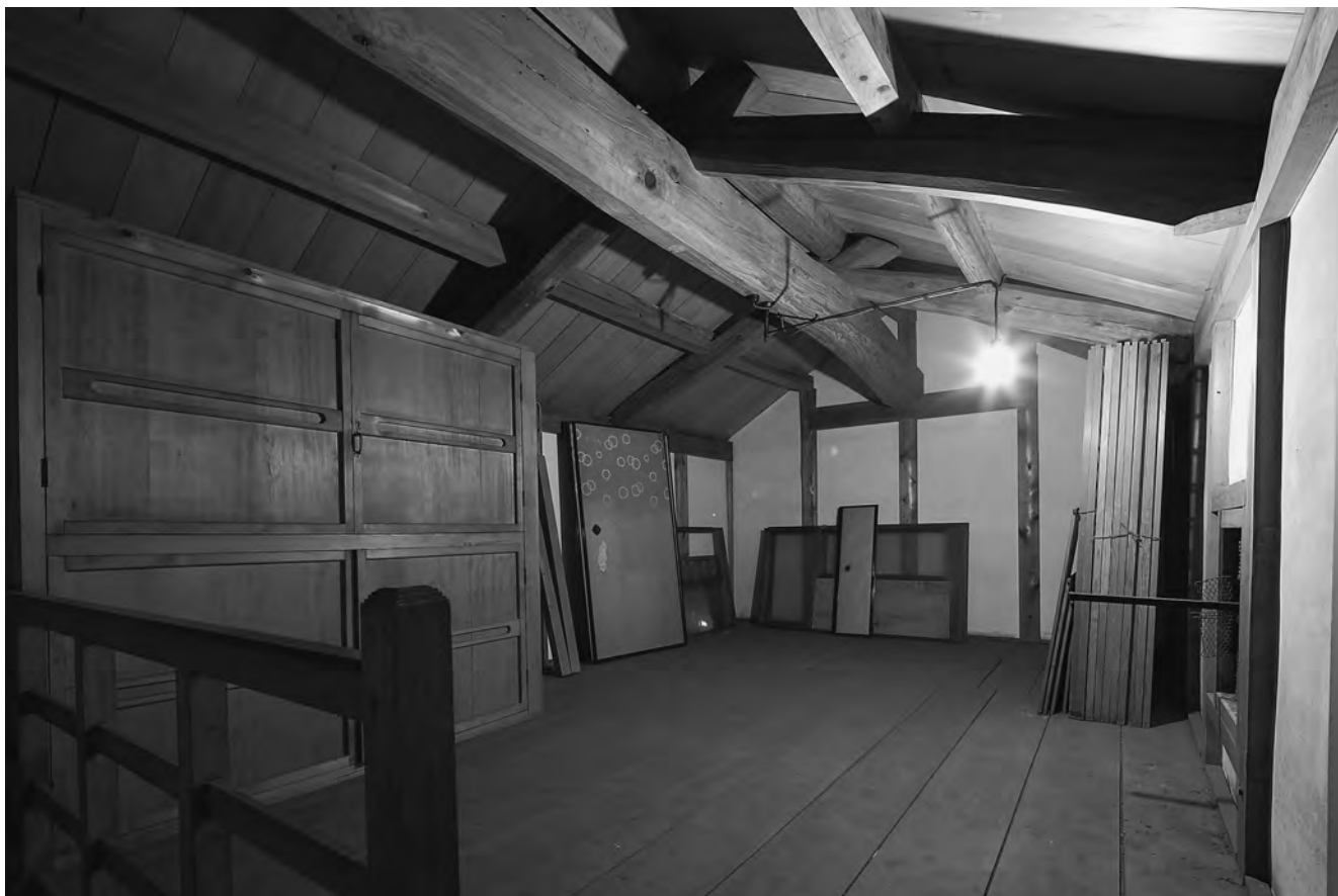
土蔵（西）二階内部 南西より
