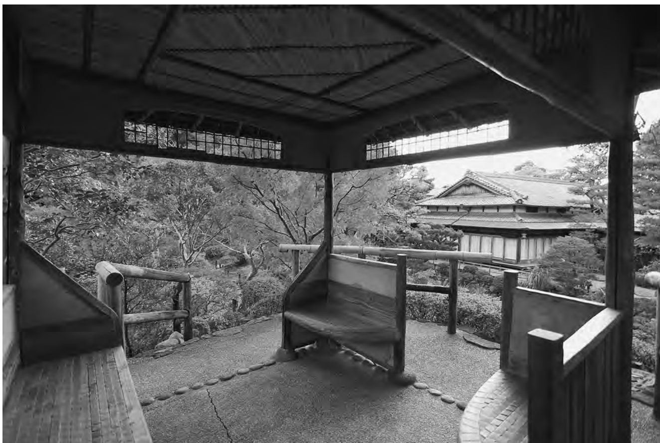
四阿（主棟を望む） 北東より
