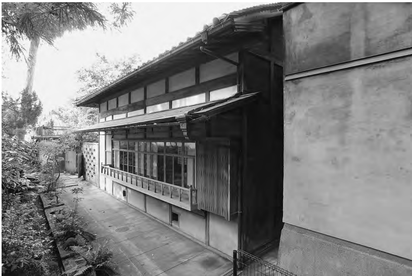
主棟（南棟）全景 北西より
