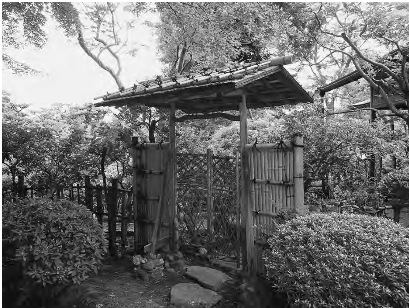
梅見門 全景 南東より
