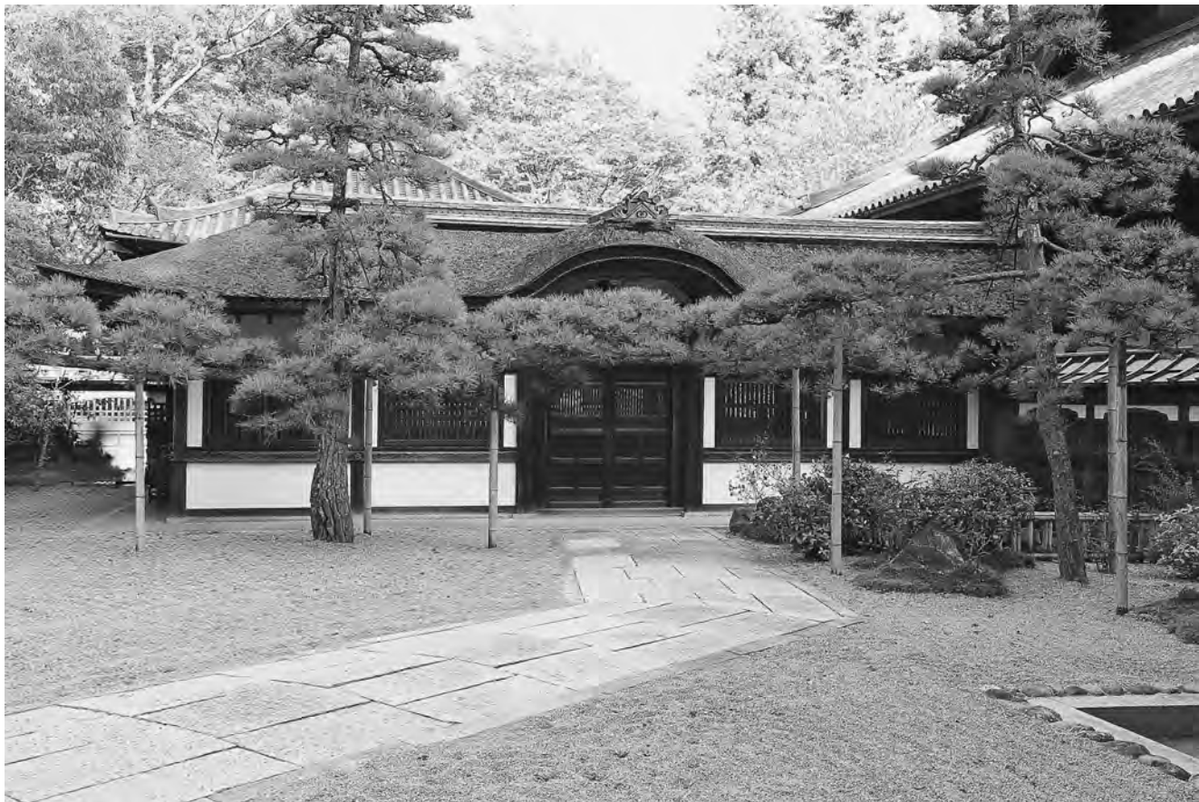
唐門・回廊 正面全景 西より
