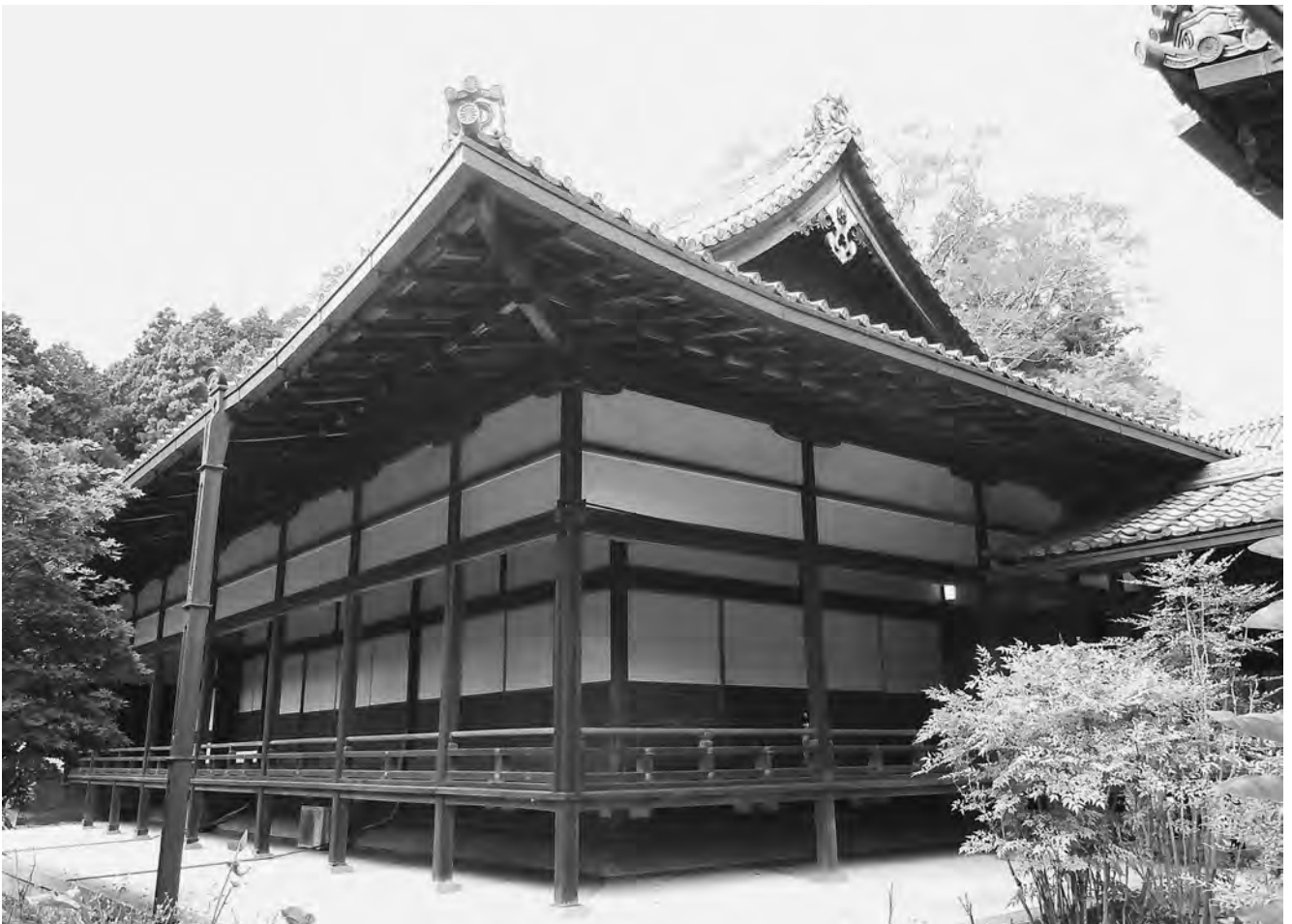
奥書院 正側面全景 南東より
