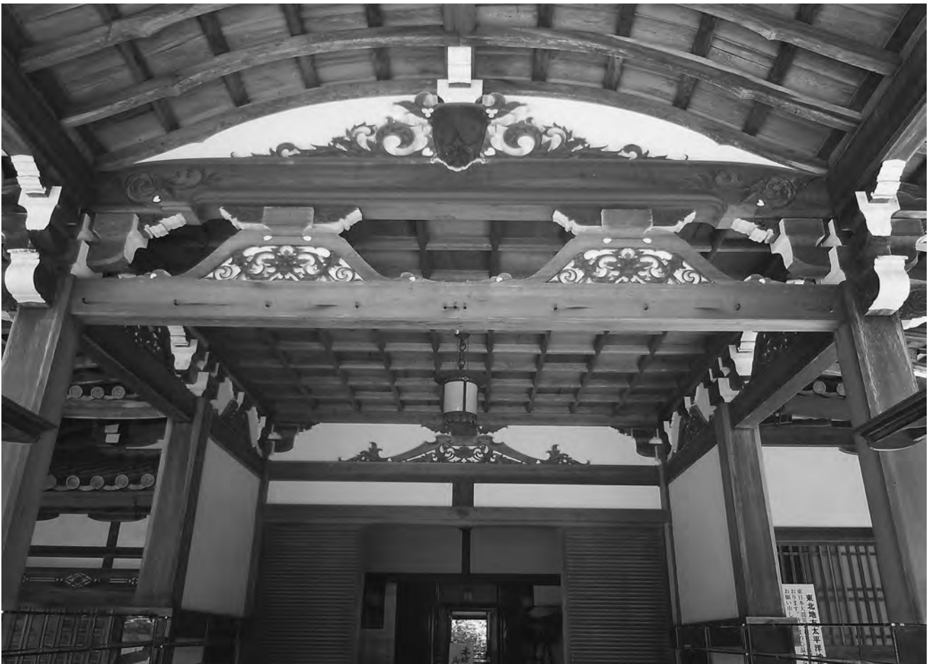
大玄関 車寄 柱上部詳細 北より
