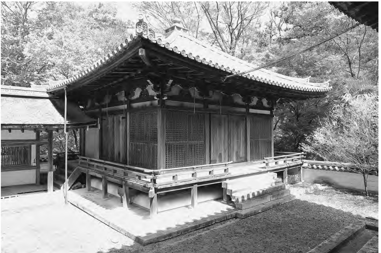
護摩堂 正側面全景 南西より
