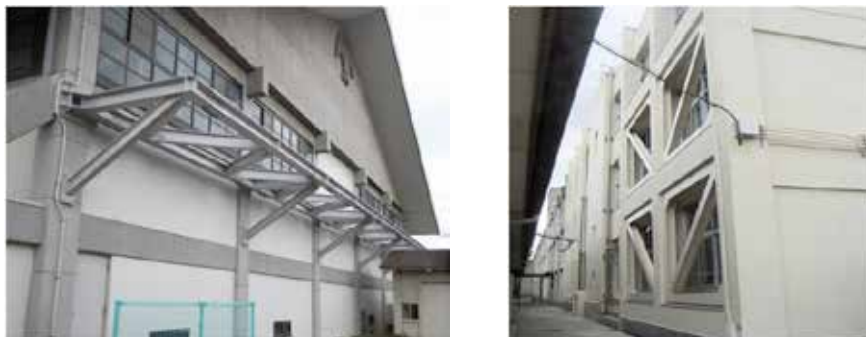
■県立高校の耐震補強例
