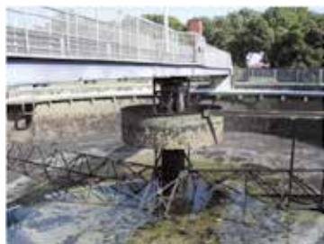
■老朽化施設の更新（最終沈殿池）
