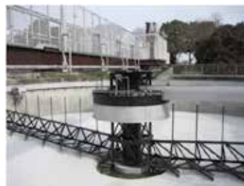
■老朽化施設の更新（最終沈殿池）
