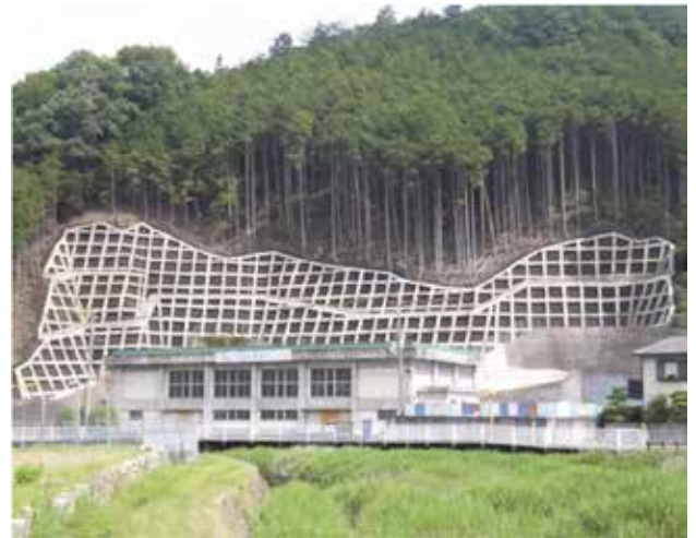
■急傾斜地崩壊対策事業(宇陀市菟田野下芳野)
