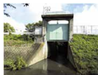
■ 岩井川逆流防止樋門
