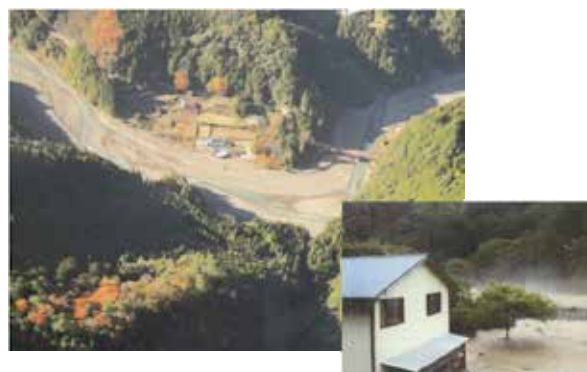
■神納川堆積土砂対策（十津川村） 洪水と土砂流出による被災状況 (H26. 8)
