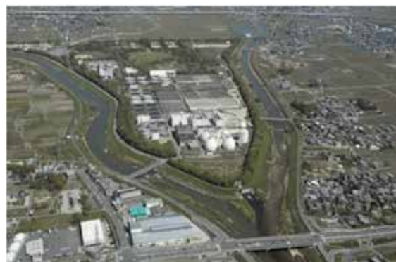
■奈良県浄化センター
