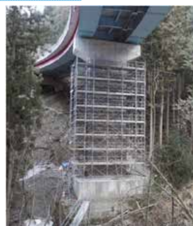
■ 橋梁耐震補強工事 (不動橋)
