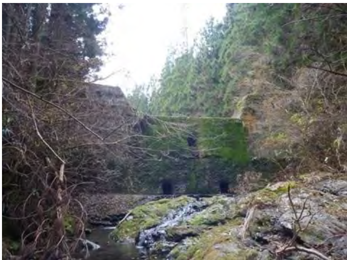
■ 老朽化した砂防施設
