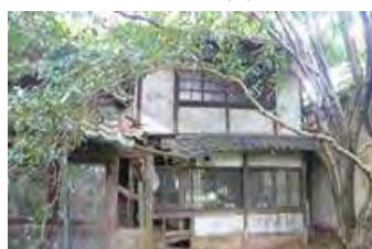
■老朽化が著しい建物
