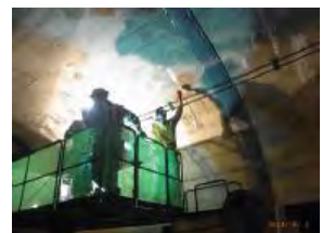
▲トンネルの点検状況
