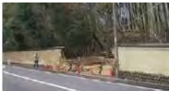
■塀の倒壊(平成22年発生)
