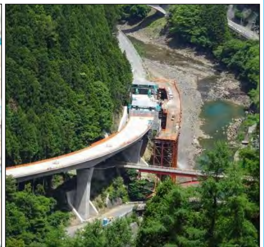
■現在施工中の堂平大橋
