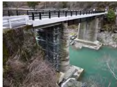
■橋梁補修工事(天川村 広瀬橋)
