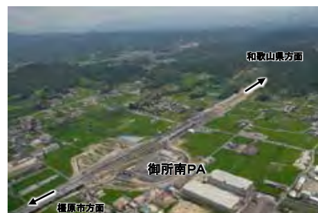
■御所南IC・御所南PA (平成29年8月19日開通)
