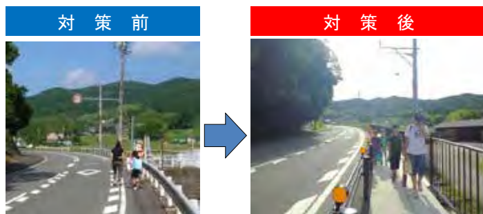
■通学路の安全対策事例（天理加茂木津線）
