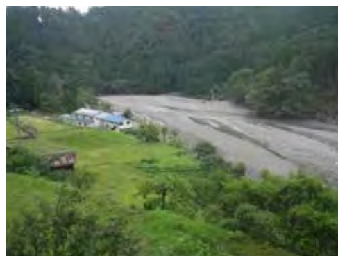
■神納川土砂堆積状況（十津川村）
