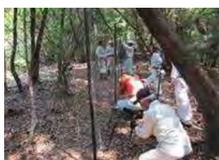
■ 植生保護柵の設置
