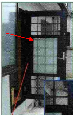
上げ下げ窓 (スライドされ、 全開の状態)
