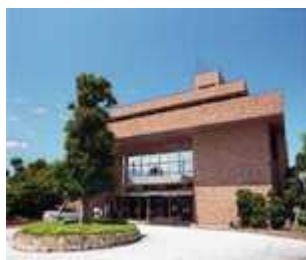
(市役所新庄庁舎)
