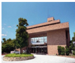
(市役所新庄庁舎)
