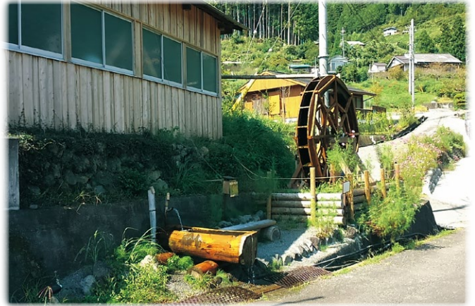
小水力発電水車(十津川村谷瀬)
