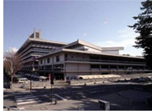
庁舎系施設 (県庁舎)
