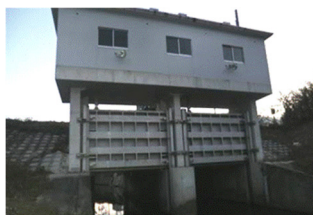
樋門 (小金打川逆流防止樋門)
