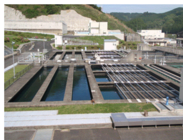
浄水場沈殿池 (桜井浄水場)
