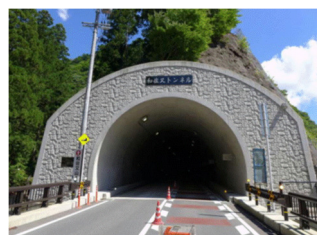
トンネル (和佐又トンネル)
