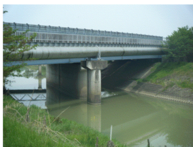
水管橋 (曾我川水管橋)
