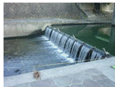
農業井堰用(改修後)
