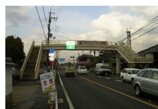
歩道橋 (都跡歩道橋)
