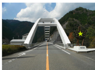
橋梁 (宇井大橋)
