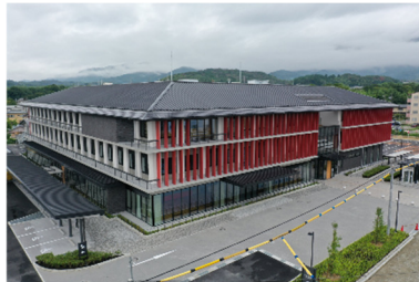
集約化した庁舎 (五條総合庁舎(五條市役所併設))
