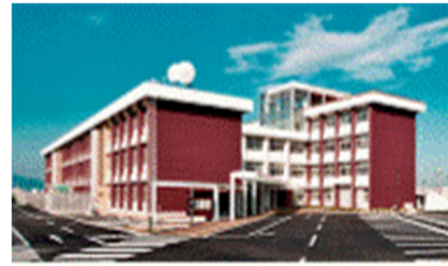
集約化した庁舎 (櫃原総合庁舎)
