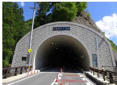
トンネル (和佐又トンネル)
