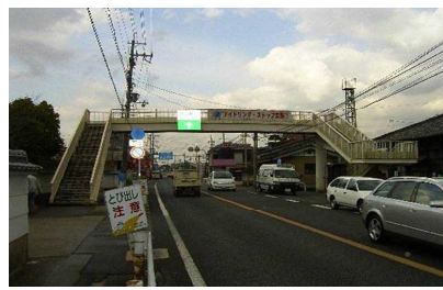
歩道橋 (都跡歩道橋)
