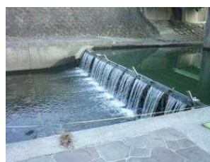
農業用井堰 (改修後)
