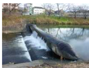
老朽化した農業用井堰
