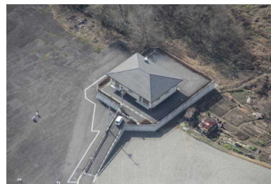
ポンプ場 (野原ポンプ場)
