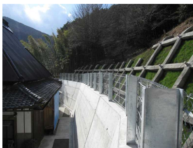
急傾斜地崩壊防止施設
