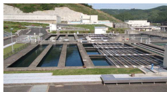
浄水場沈でん池
