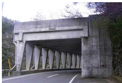
ロックシェッド (芦廻瀬洞門)
