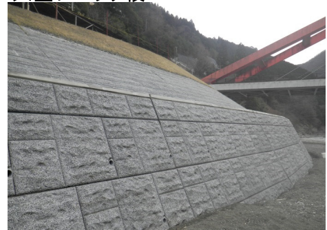
大型ブロック積工
