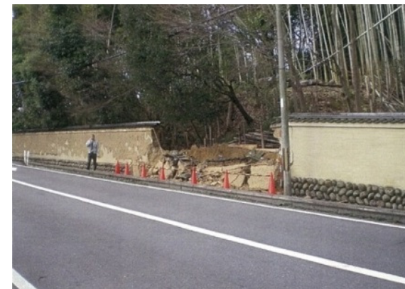
塀の倒壊（平成22年当時）
