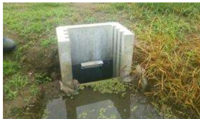
【排水樹の整備】
