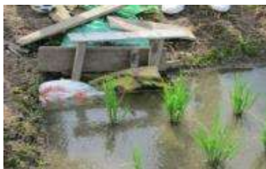
【排水口の老朽化】
