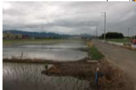
↑ 暗渠排水の整備
