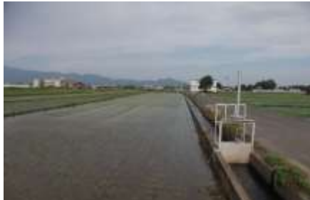
↑ 用排水路の整備
