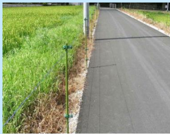
アスファルトのすぐ横に電柵設置 (電圧低下)
