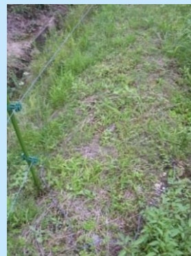
電柵の線が切れている
