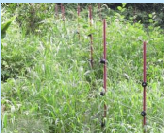
草による漏電で電圧低下
