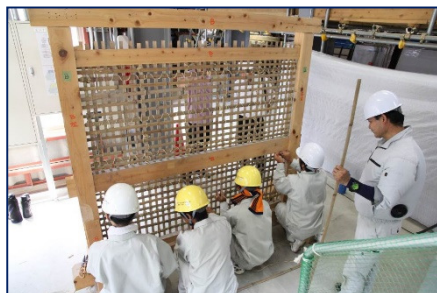
左官作業実習 写真
