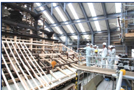
本堂修理状況見学 写真
