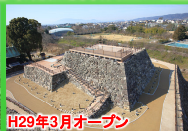
①郡山城天守台展望施設
