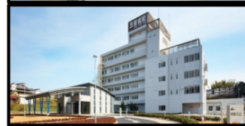
五條病院（90床） ・県立五條病院を改修 ・平成29(2017)年4月 リニューアルオープン
