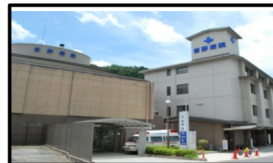
吉野病院（96床） ・国保吉野病院を改修 ・平成28(2016)年4月 リニューアルオープン
